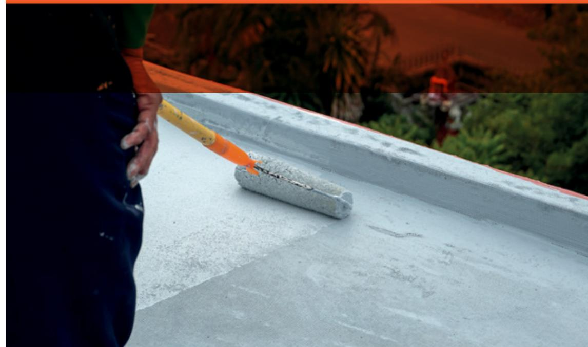
Revestimiento impermeabilizante elastomérico de poliuretano alifático en base agua para cubiertas, cuando se requiera durabilidad mecánica y excelentes propiedades impermeabilizantes. Forma una película impermeable a la humedad, resistente a los rayos UV y al estrés mecánico.
